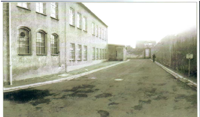
Das 4.000 qm große Areal des Geschlossenen Jugendwerkhofs Torgau war von einer etwa drei Meter hohen Mauer umgeben und mit Suchscheinwerfern und Wachhunden gegen Fluchtversuche gesichert. An den Eckpunkten standen Wachtürme, von denen aus Hofbereich und Eingangsschleuse überblickt werden konnten. Fenster und Türen waren massiv vergittert, selbst die einzelnen Gebäudeteile waren im Inneren durch Gitter getrennt. Eine detaillierte Sicherheitsordnung umfasste auch eine "Wachordnung" sowie eine "Schlüsselordnung". Sie regelte die Kontrollgänge, die Aufgaben der Betriebswache und der Hundeführer.
