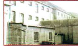
Schleusenbereich mit Blick auf den Zellentrakt, Foto um 1978.
