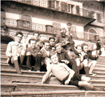
Treppenanlage zur Elbe / Schoß Pilsnitz
