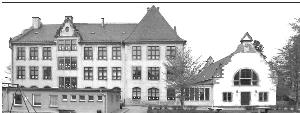
Bild: Rückseite der Fichteschule >Schulhof mit Toilettenanlagen< rechts Turnhalle.
