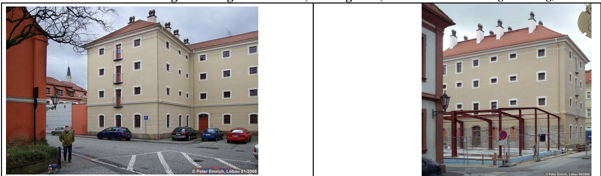
Verschiedene Ansichten >ehemaliger Zellentrakt - jetzt Büronutzung
