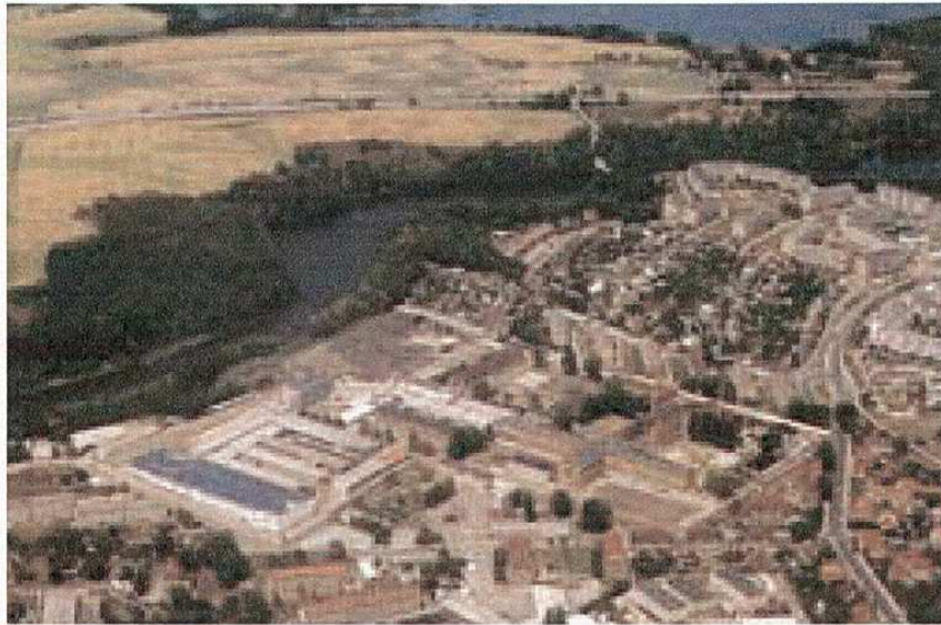
Die Landesstrafanstalt von Süden 1992 und um 1910 (Bild unten)
